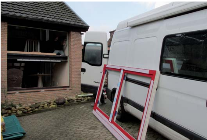
Die neuen Fenster sind auf der Baustelle angekommen Bild: mbz
