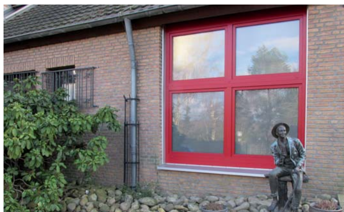
Vorher – Nachher. Die Glasbausteine wurden durch ein modernes, energieeffizientes und schallhemmendes Fenster ersetzt. Foto: mbz
